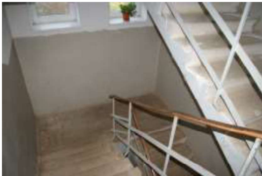
Būve ar kadastra apzīmējumu 6415 007 0010 005, koplietošanas telpa
